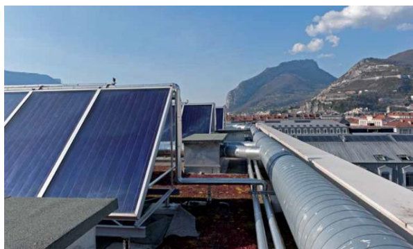
Figura 34 – Painéis fotovoltaicos do ZAC De Bonne. Fonte: Grenoble-Alpes Métropole Aménagement (2019).
