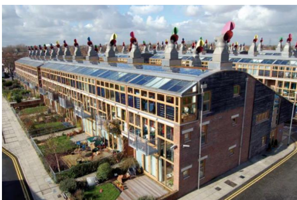
Figura 18 – Fachada dos prédios do BedZED, com destaque para as chaminés. Fonte: Bioregional (2009).
