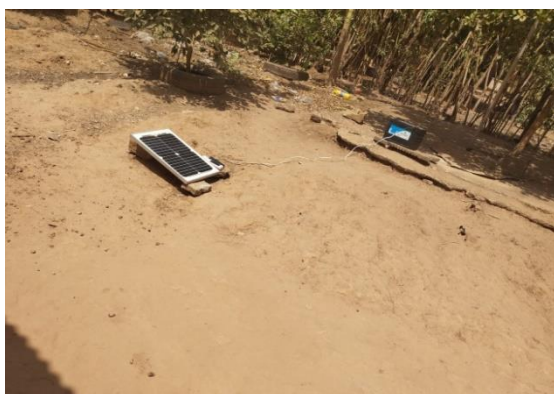
Figura 19 -Painel solar de baixa potência utilizado para carregar a bateria para garantir a iluminação ao por de sol.
