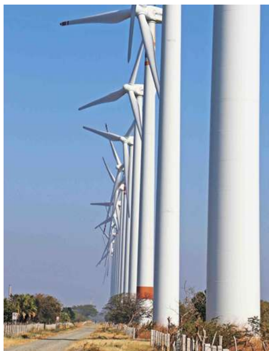
Figura 14. Parque eólico Oaxaca II-III-IV del Grupo Acciona en el Istmo de Tehuantepec.
