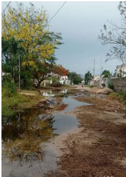
Figura 8. Calles sin pavimentar, donde la parte transitada se compacta e impermeabiliza.
