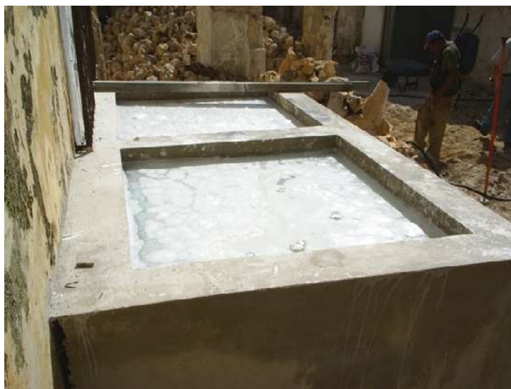
Figura 2. Apagado de cal en artesas tradicionales. Fuente: Elaboración propia.
