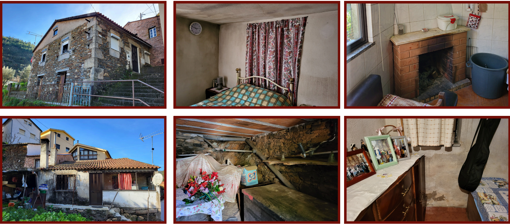
Fig. 4. Fotografias tiradas durante a visita de inspeção
