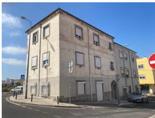
Figura 4.14— Edificado em Falagueira Venda Nova.
