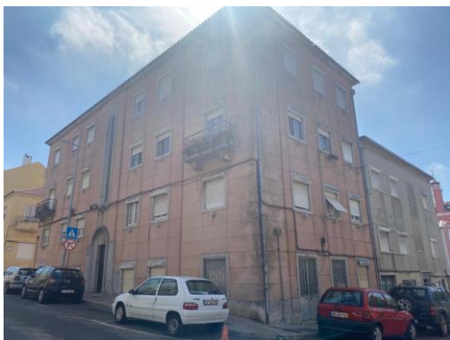
Figura 4.14— Edificado em Falagueira Venda Nova.
