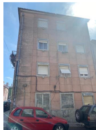
Figura 4.14— Edificado em Falagueira Venda Nova.
