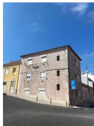
Figura 4.14— Edificado em Falagueira Venda Nova.
