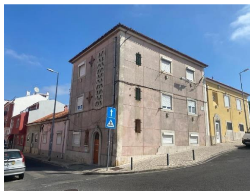
Figura 4.14— Edificado em Falagueira Venda Nova.
