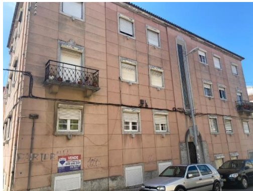
Figura 4.14— Edificado em Falagueira Venda Nova.
