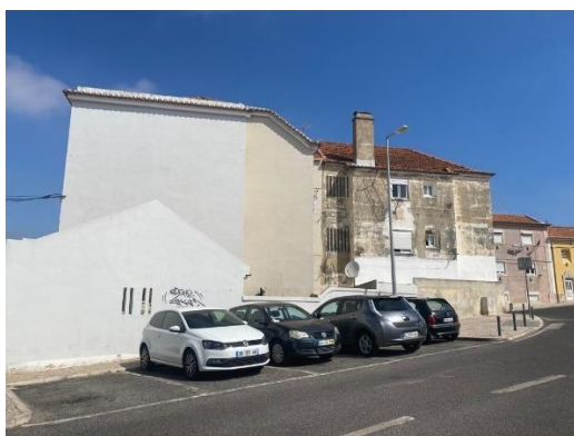
Figura 4.14— Edificado em Falagueira Venda Nova.
