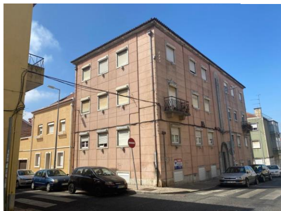
Figura 4.14— Edificado em Falagueira Venda Nova.
